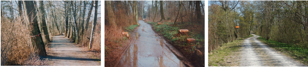
Der Weg entlang des Alten Rheins vor Baubeginn, nach der Rodung und nach Bauabschluss
